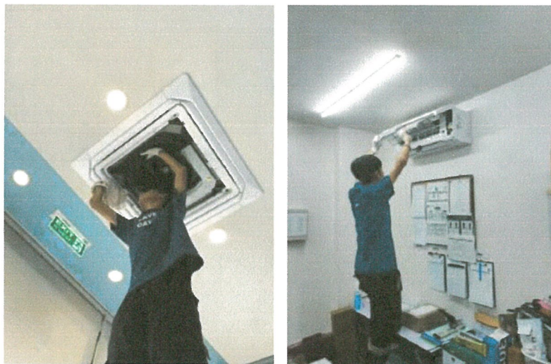
รูปภาพที่ 2.38 การล้างทำความสะอาดเครื่องปรับอากาศ
